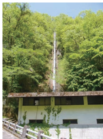
JAびほく・羽山発電所の発電所建屋と導水管。山頂から建屋まで約150mの高さから水を落として発電しています。最大出力495kW。
